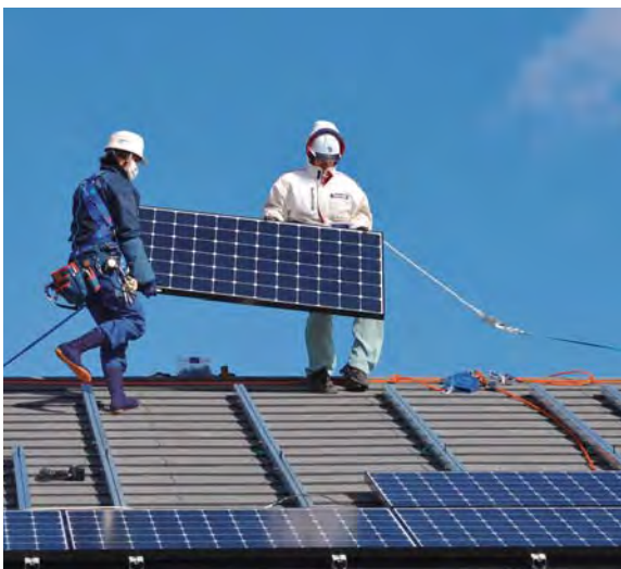
実際に行った施工写真です。ハーネスと呼ばれる安全ベルトを付け安全管理をしっかり行った上で作業をしています。
