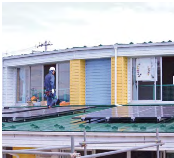
郡山市内の保育所にNPO法人ふくしま再生可能エネルギー普及促進センターから太陽光発電設備を寄付することになりました。施工写真となります。
